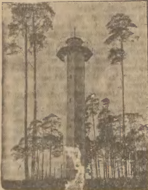
W Grunewaldzie, w okolicy Berlina, dla użytku Instytutu Topograficznego wybudowano pierwsze żelazo-betonowe wieże obserwacyjne
