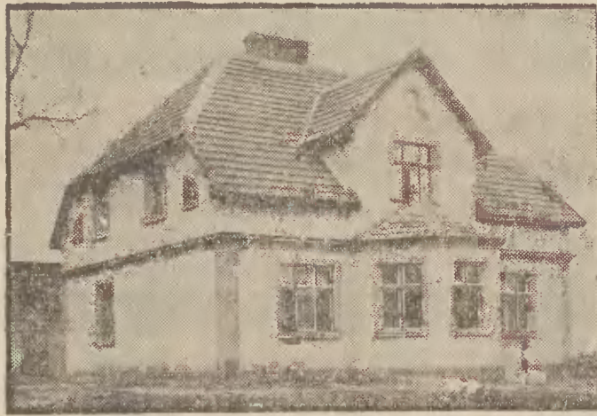
Nowa budowa naszego członka urzędnika kolejowego p. Bernarda Bieszki, Smolno, pow. Morski
