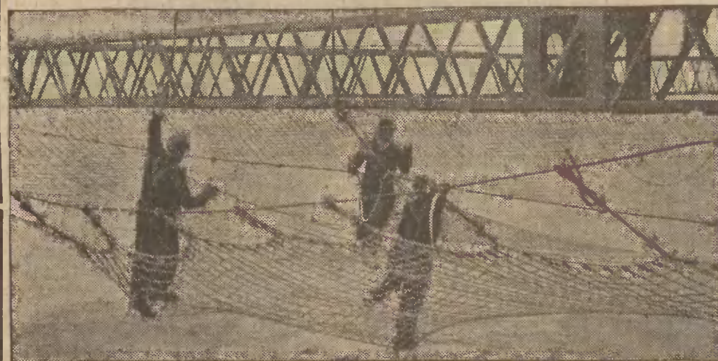
Abym uchronić robotników pracujących przy moście Golden-Gate w San Francisco przed upadkiem z olbrzymiej wysokości, rozpięto pod przęsłami mostu siatki, jakich używają akrobaci
