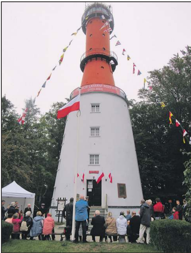
Latarnia Morska w Rozewiu
