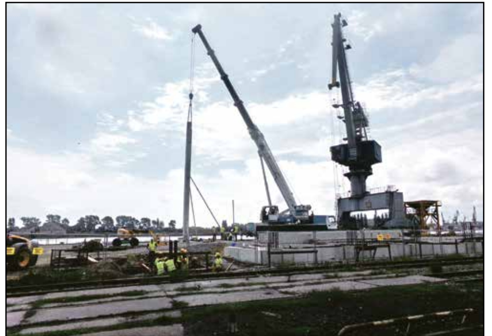
Realizacja inwestycji przebiega bardzo sprawnie. Tak wyglądał plac budowy 10 lipca...
