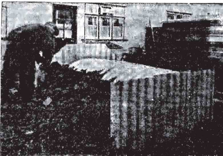
Rząd angielski przystąpił do produkcji małych, składanych schronów przeciwgazowych. Oto jeden ze zmontowanych schronów w ogródku podczas przykrywania ziemią.
