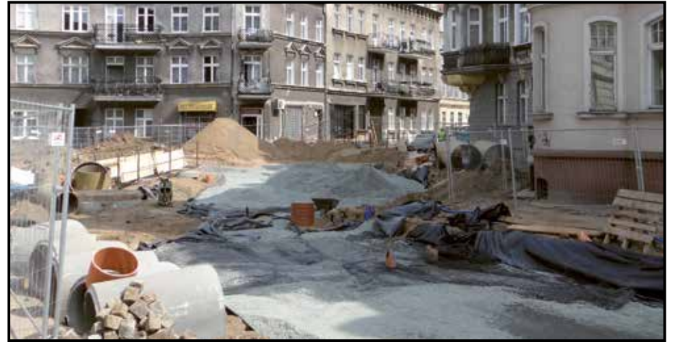
Ulica Wajdeloty w trakcie rewitalizacji
